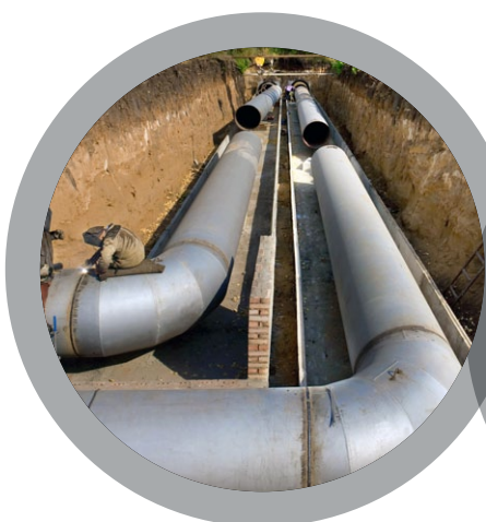
Трубопроводные стыки
